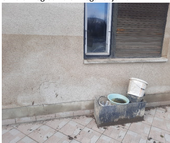
Slika 5: Vertikalna razpoka pod oknom
