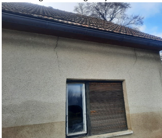
Slika 6: Vertikalna razpoka na V fasadi
