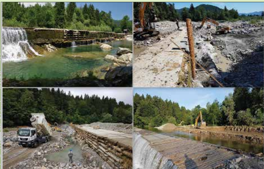
Obnova Grušoveljskega jezua
