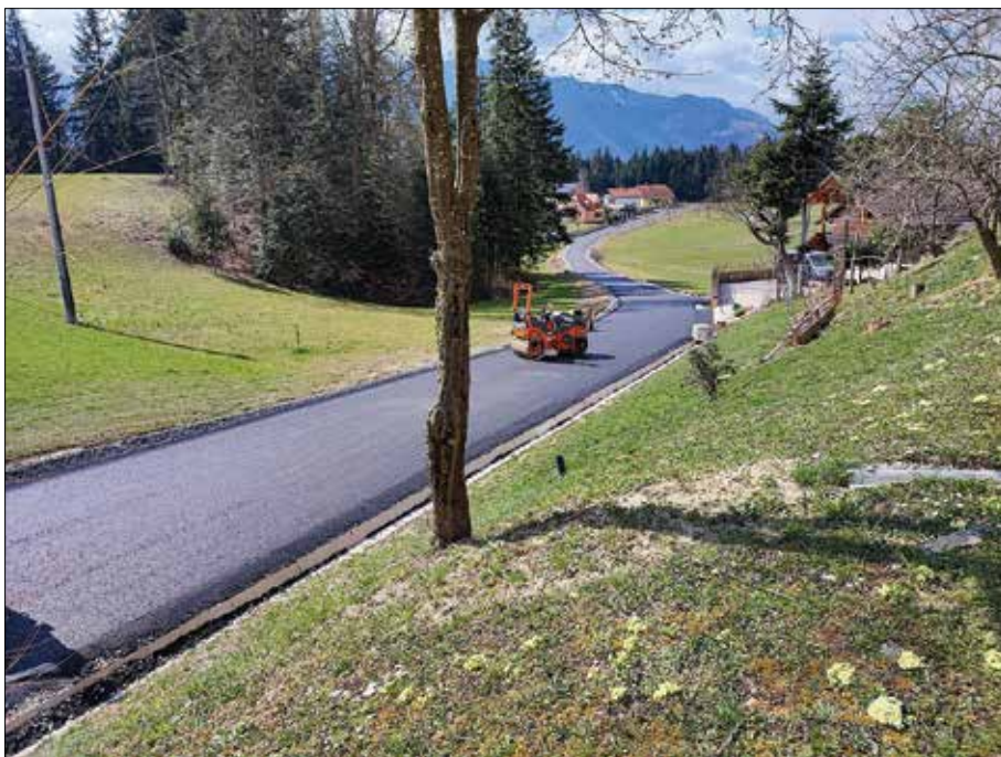
Gradnja nadomestnega odseka na Homcu
