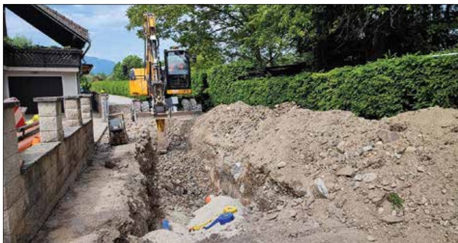
Med obnovo ceste v Spodnji Rečici so se gradili novi vodi, kar je nekoliko podaljšalo čas obnove.
