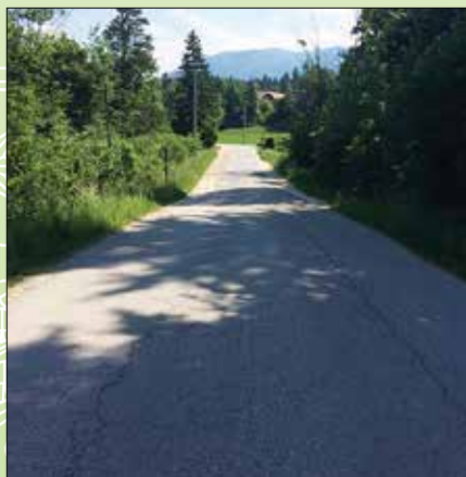
Med gradnjo vodovoda se bo obnovljala tudi cesta.
