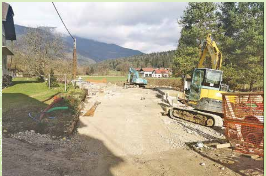
Dela na mostu
